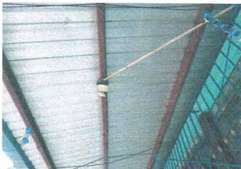
Reparación de Sistema Eléctrico exterior
