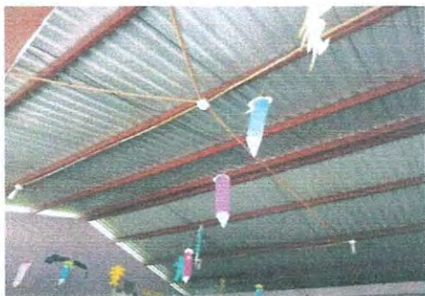
Reparación de sistema eléctrico
