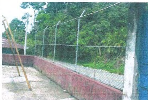
Sustitución de malla, pintura de muro interior y exterior
