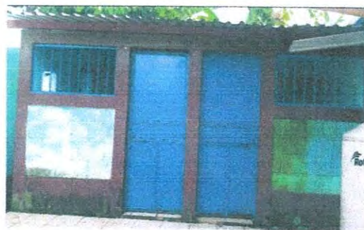
Sustitución de pintura de exterior e interior de cocina
