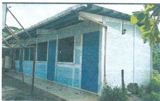
Sustitución de pintura de exterior e interior de aulas
