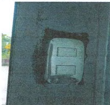
Sustitución de apagador
