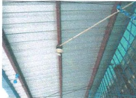
Reparación de Sistema Eléctrico interior
